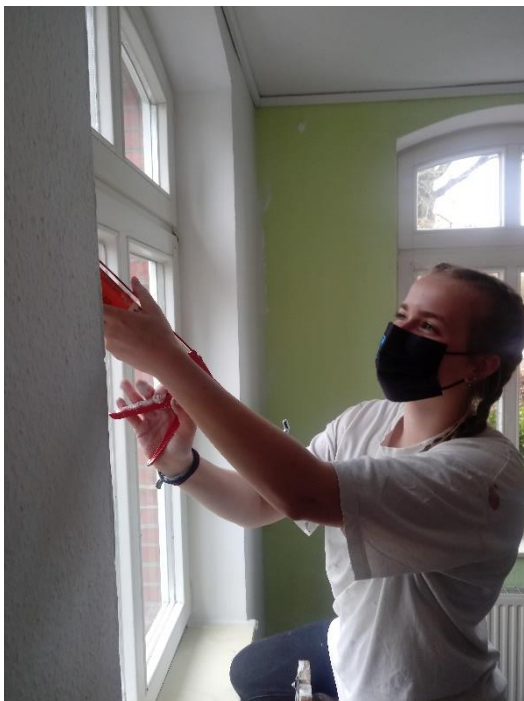
Foto: Wo unterschiedliche Farben aufeinander treffen wird zuerst eine Naht aus Acryl angebracht, hier Emily Müller.
